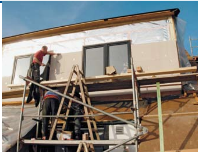
Die energiesparende Luft- und Dampfsperre hat eine diffusionsäquivalente Luftschichtdicke von circa 150 Meter. Die hohe Sicherheitsreserve schaltet Diffusionsvorgänge langfristig aus.
