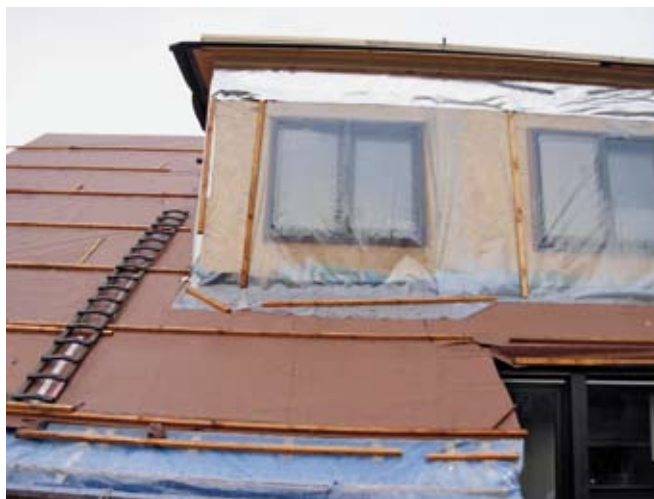
Auf der Holzschalung wurde eine diffusionsoffene Schalungsbahn mit integrierten Klebezonen an beiden Rändern verlegt.
